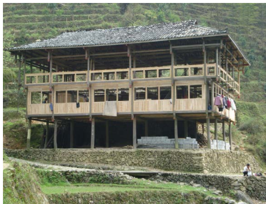
Ping'an (Guangxi), reconstruction d'une maison dans le style Miao local, en utilisant une structure existante (2007)
