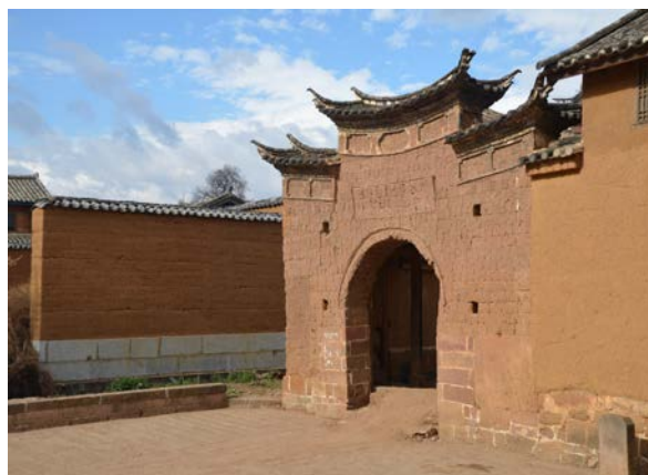
Shaxi - Porte restaurée à l'entrée sud, selon une ancienne technique utilisant le torchis (2015)
