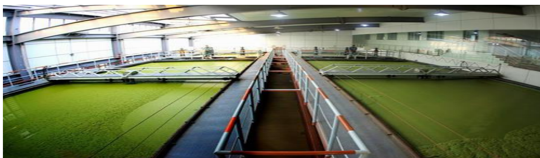
Une usine de traitement des algues près du lac Tai.
